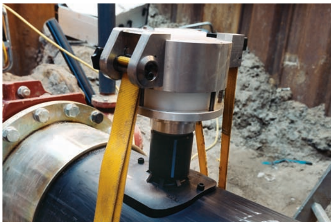
Прижимное устройство FRIATOP работает пневматически и прижимает перед сваркой фасонное изделие седловидной формы к трубе из ПЭ.
