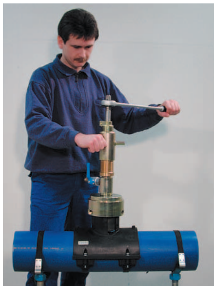
Рис 2: Врезка в безнапорный трубопровод при помощи приспособления для врезки фирмы Hütz + Baumgarten
